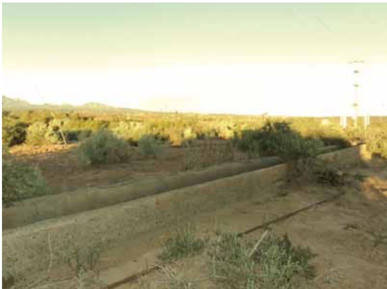
Canales que conducían el agua extraída al petróleo al río Colorado en la planta de tratamiento de crudo de Puesto Hernández, a escasos veinte kilómetros aguas arriba del actual Rincón de los Sauces. (Fotografía del autor)
