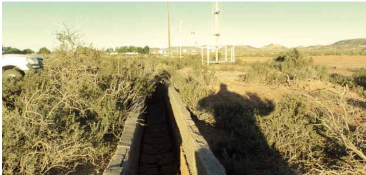
Estas especies de canaletas, canales o acequias, realizadas con cemento, hierro y ladrillos, por casi veinte años condujeron el agua extraída de la separación del petróleo producido en Puesto Hernández y las zonas cercanas a este, al cauce del río Colorado. Estas conducciones fueron construidas por YPF en los inicios de la industria petrolera con el fin de llevar altos caudales de agua hasta el cauce del río. Las acequias eran varias, y por ellas se conducía toda el agua que hoy se re-inyecta a la tierra en el proceso denominado recuperación secundaria. Dicho proceso, a la vez que ayuda a la producción de petróleo, evita que esta agua, contaminada, sea arrojada a los campos o al río como se había hecho durante muchos años. (Fotografía del autor)
