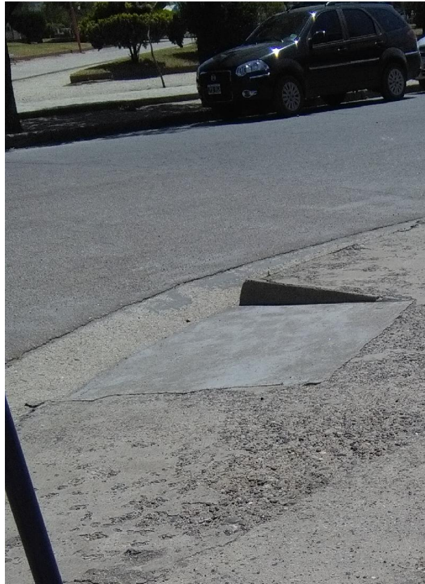
7- Rampa para discapitados en las esquinas.
