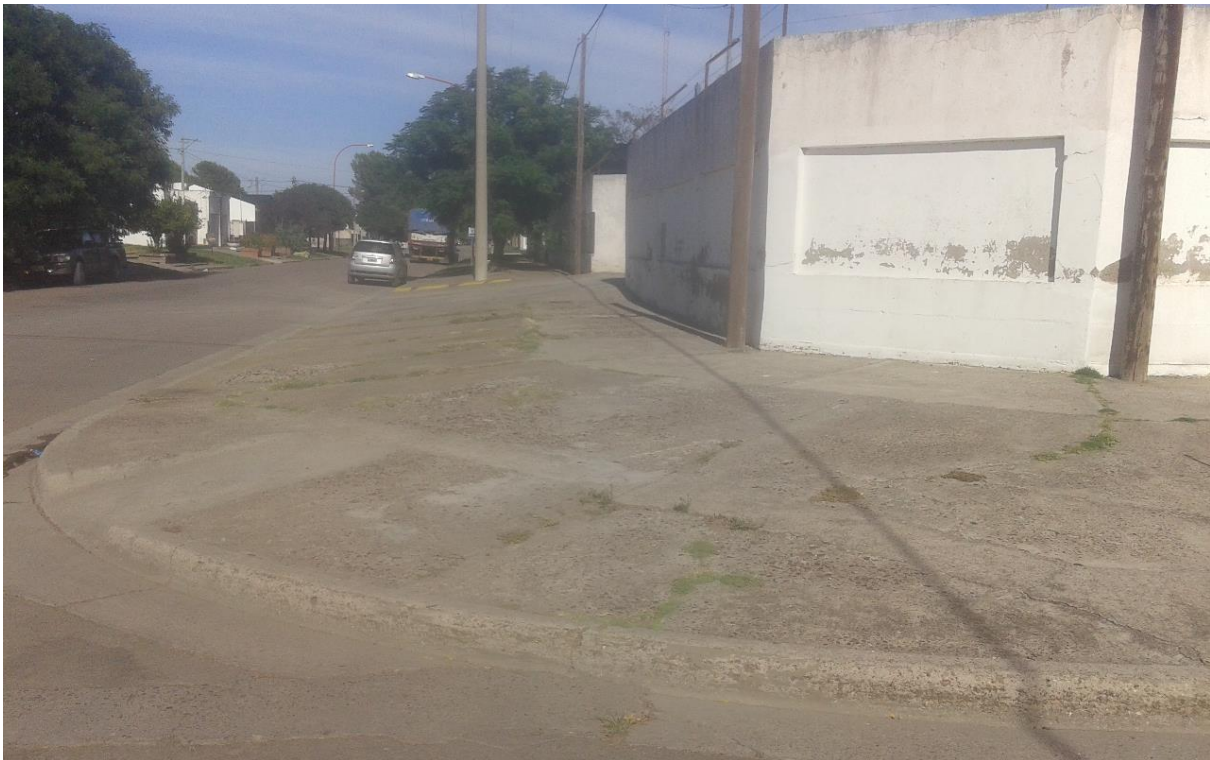
8- Ochava, demoler contrapiso existente y rehacer con alisado de cemento, ídem referencia N°2.
