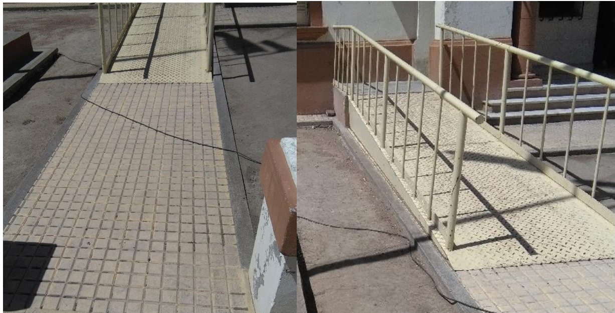
14- Entrada principal, construir rampa.
