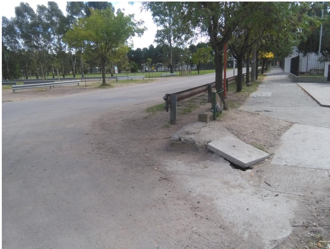
Foto esq. Acc. Norte y Calle 9 de Julio. Tapa de inspección y alas de alcantarilla peligrosa.
