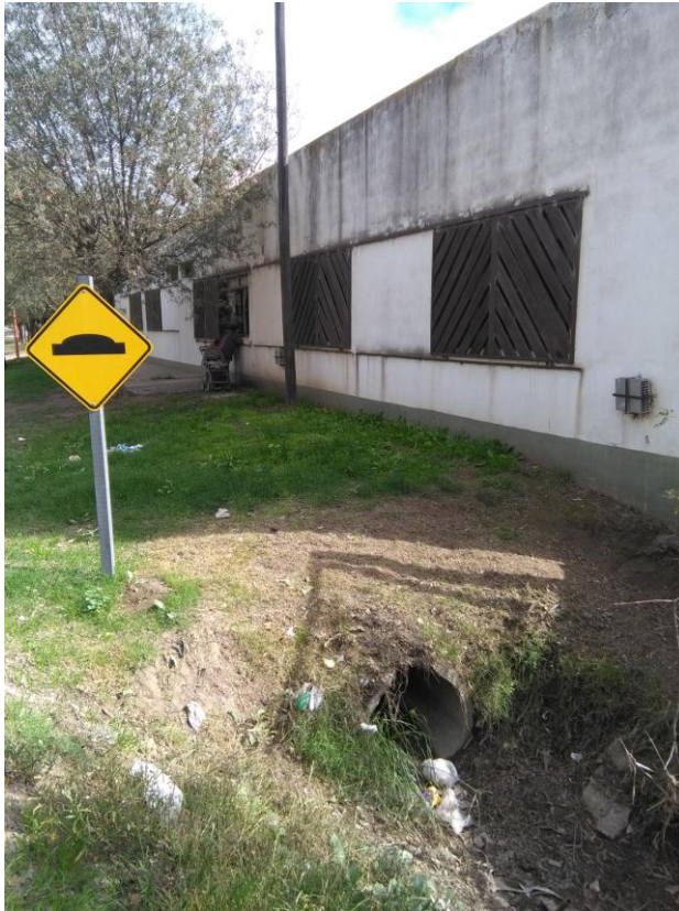
Foto vereda Establecimiento Educativo sobre Calle 9 de Julio. Tramo de Alcantarilla y vereda faltante.
